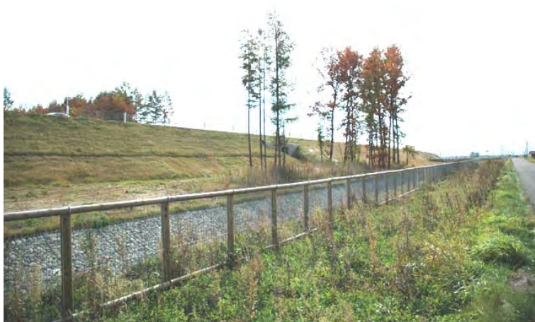
帯広広尾自動車道・帯広市
