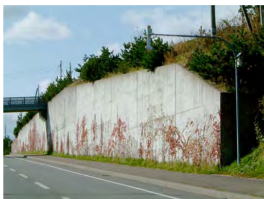
今後の成長が期待される、擁壁へのツタによる緑化（国道 278 号・函館市）
