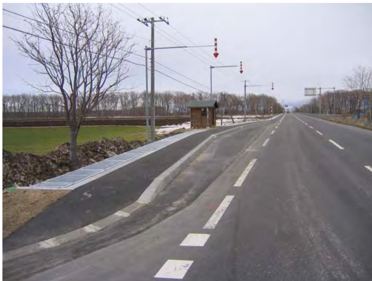
国道 244 号・斜里町美咲
