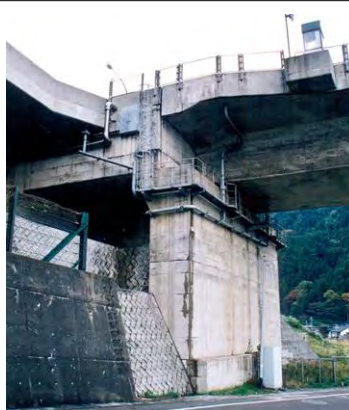
図 8.2.10 下部工付検査路の現状
