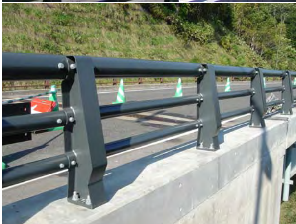
ガイドラインに基づき美笛グリーンに塗装された奥漁川橋（写真・上）と、美笛グレーの冬笛橋（写真・下）
