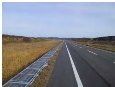
無積雪期の景観にも配慮した収納式防雪柵を設置している事例。(道道稚内天塩線・稚内市)
