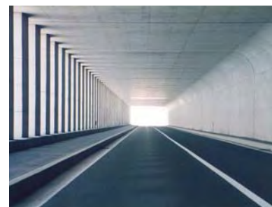
ハンチの無い細い柱が整然と並び、シンプルで良好な内部景観が形成されている。
