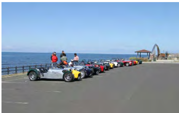
眼前に広がる日本海の景観を活かすため、立上りの構造物を極力抑え、視線を遮らない防護柵のみとしている。(国道 232 号・小平町)
