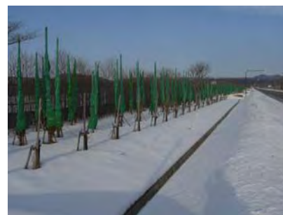
用地界に防雪柵を整備し、前面に植栽による遮蔽を施すことにより良好な道路景観が実現している事例。(道道52号・弟子屈町)
