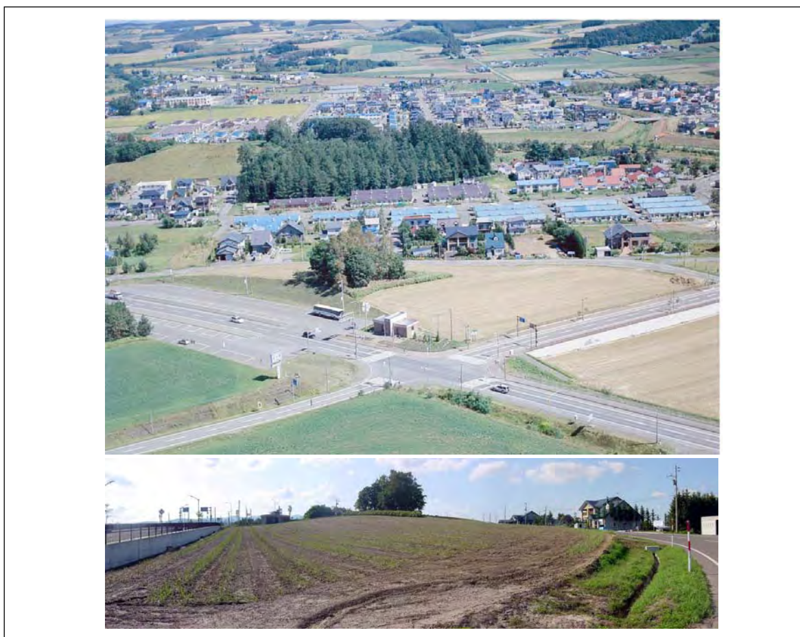
図 5.9.2 現地の状況（整備前）
