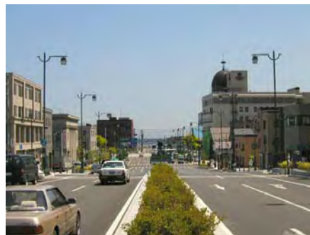
地域の歴史・文化に配慮した道路
