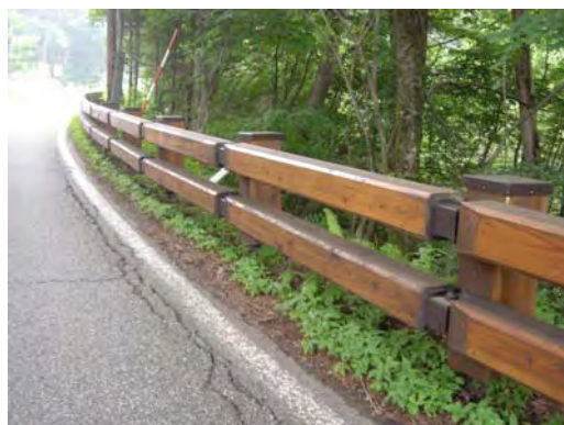
車両用木製防護柵（長野県）
