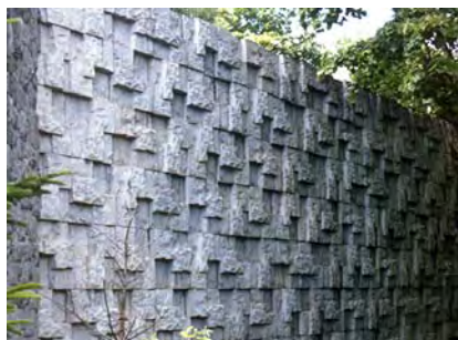
大きな段差があるブロックを回転させながら用いることで、表情豊かな面を生み出している。
