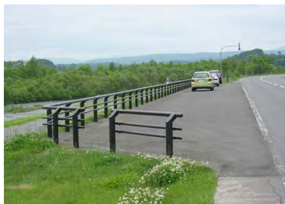
羊蹄山と尻別川を望む地点に設けた駐車帯 (国道 276 号・京極町)
