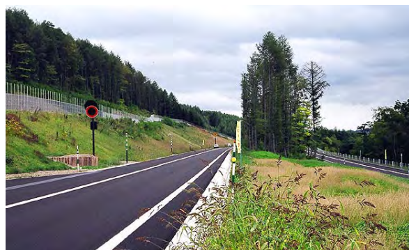
中央帯を広くし、上下線に高低差をつけて暫定供用した道路の事例。既存林も残している。 (道央自動車道士別～剣淵間)
