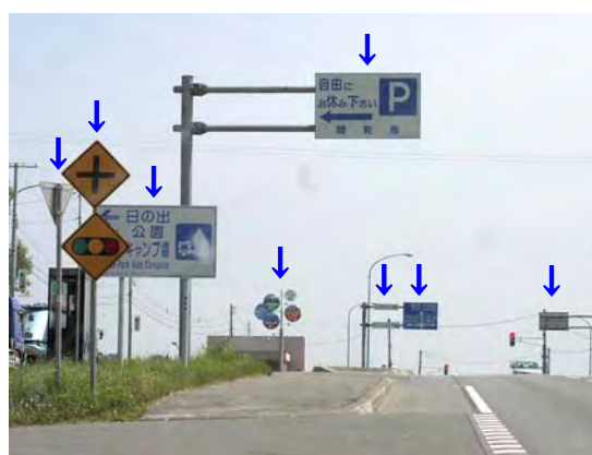
標識がそれぞれ単独で設置されていて整理されていないため、道路利用者に煩雑な印象を与えている
