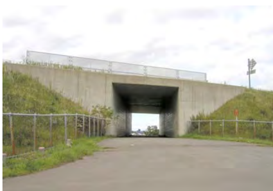
ハンチを省略し盛りこぼしとしているため、比較的シンプルな外観が得られている。
