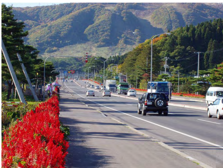
国道5号・七飯町
