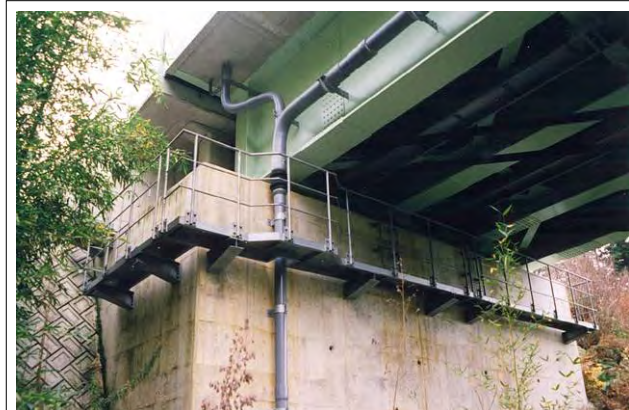
図 8.2.10 下部工付検査路の現状
