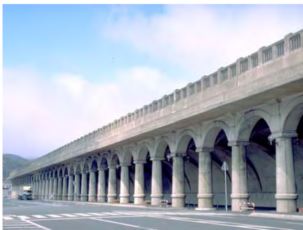
地域のシンボルともなっている防波堤の事例。コンクリートの造形における特長は可塑性にあり、自由に形態を生み出すことができる。造形で魅力を持たせる場合には、平滑面がふさわしいことが多い。
