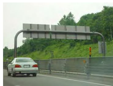
平滑なパネルの設置
