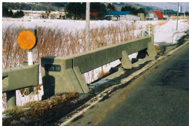
構造技術や計画技術を駆使して誕生した製品が、北海道で大量に使われた結果、北海道を代表するスタンダードとして認知された例。左は高橋敏五郎が弾丸道路(国道36号千歳札幌間道路、昭和29年)で考案した傾斜型高欄の亜種(写真は国道5号幌内橋、長万部＝現在は撤去)、右は岡崎文吉が原始河川だった石狩川の浸食を防止するために考案したコンクリートマットレス(単床ブロック工法、大正2年創設、写真は江別に現存)。
