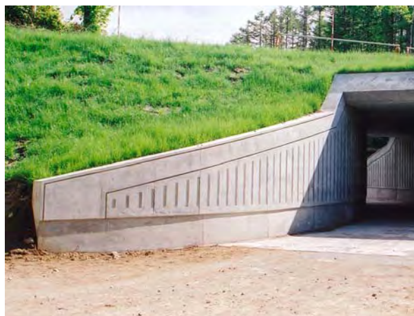
構造物全体の造形に合わせて、洗い出し仕上げをスリット状に設けることで表情を生み出している函渠。天端に勾配を持たせるとともに水切りのためのスリットを設けて汚れに配慮している。
