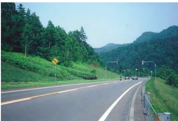
遷移が進む緩傾斜のり面
