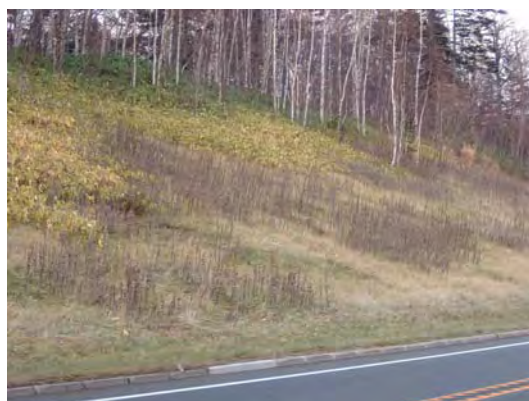
緩勾配切土のり面に周辺からの植生侵入が進んでいる（国道230号・中山峠）
