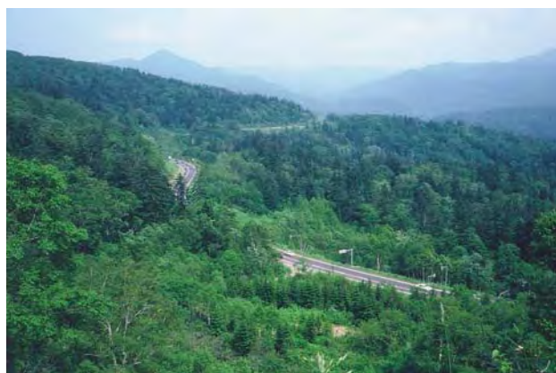
旧道から見た定山溪国道
