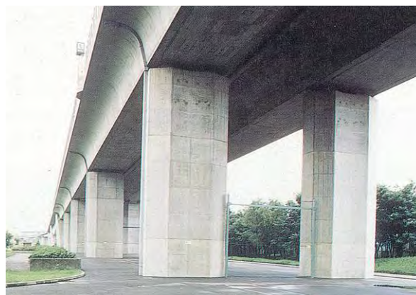
リブや面取りにより橋脚に陰影をつけることで、近くから見られても質感が高いデザインとしている事例(出典:資料6)
