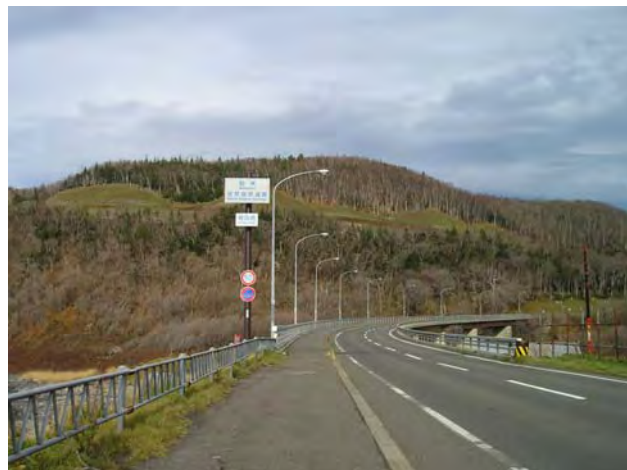
片持ち式標識により景色が妨げられていた事例（左）。路側式標識とすることで景観が保全された事例（右）
