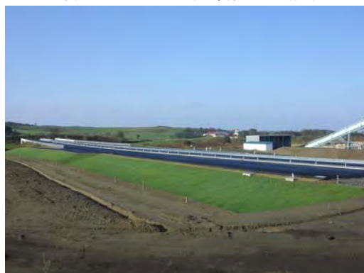
国道40号豊富バイパスの緩勾配盛土
