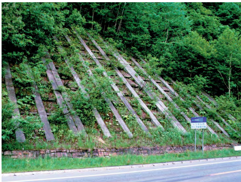
国道 230 号・札幌市
