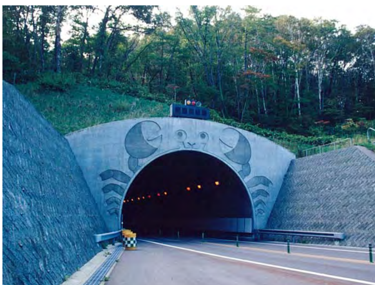
道央自動車道・室蘭市
