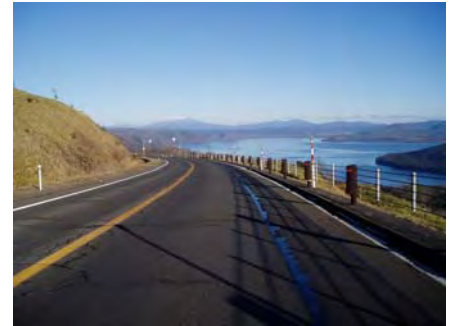
のり面へのラウンディング、眺望を阻害しない防護柵
