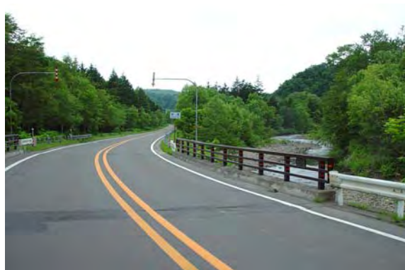
中位の自然特性の例：ありふれた樹林と溪流だが、道路以外の人為の施設がなく、自然環境を満喫できる
