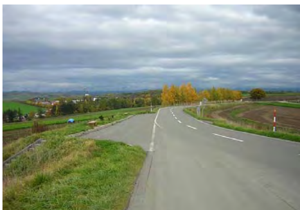
地域の個性である丘陵景観のなかに設けられた駐車帯 (美瑛町)
