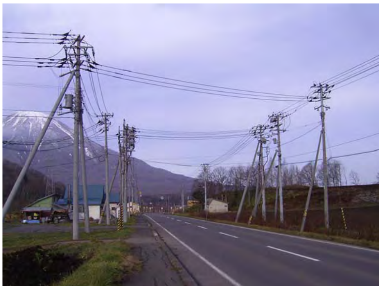
国道 276 号・喜茂別町
