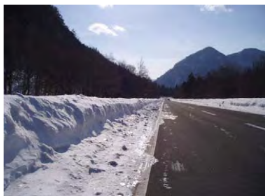
防護柵設置により雪堤が高く発生している区間
