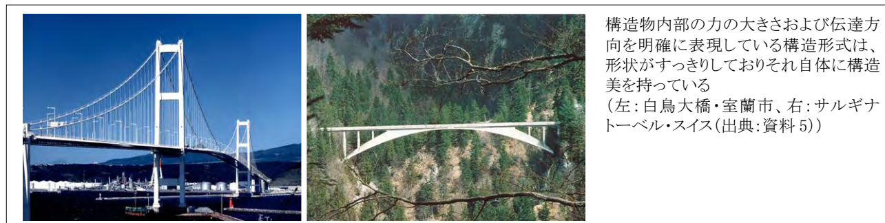
図 8.2.1 力学的に明快な構造の例
