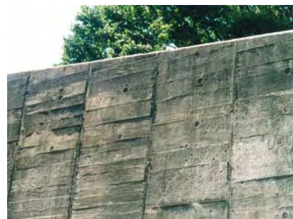
杉小幅板を型枠に用いた壁面。表面の汚れを利用し、石のような風合いを生み出している。
