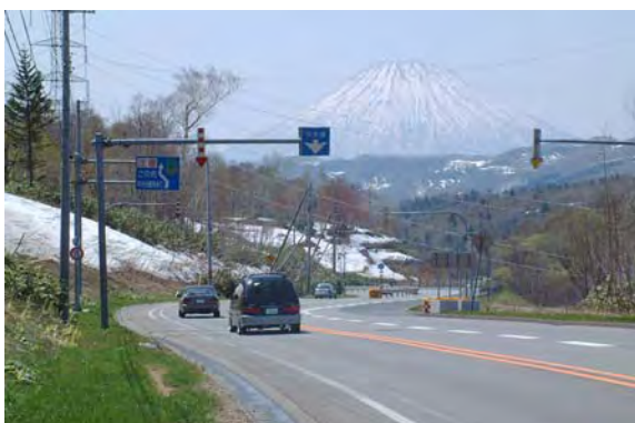
好ましくない内部景観： 良好な景観が電柱・電線や道路付属物で阻害されており、悪印象を与える
