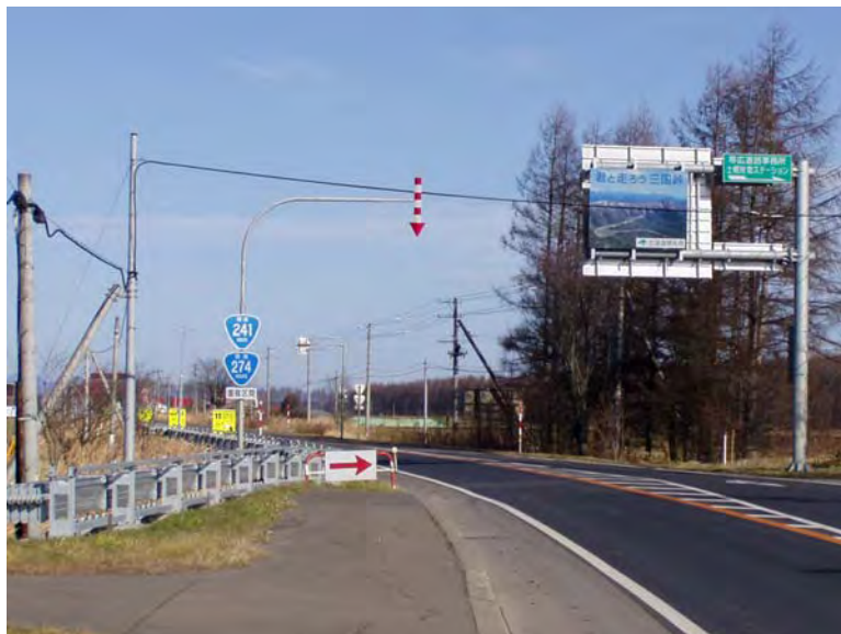
国道 241・274 号・土幌町
