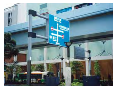
パネルを一体型にし、柱の接合部を工夫した新型柱
