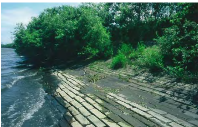
構造技術や計画技術を駆使して誕生した製品が、北海道で大量に使われた結果、北海道を代表するスタンダードとして認知された例。左は高橋敏五郎が弾丸道路(国道36号千歳札幌間道路、昭和29年)で考案した傾斜型高欄の亜種(写真は国道5号幌内橋、長万部＝現在は撤去)、右は岡崎文吉が原始河川だった石狩川の浸食を防止するために考案したコンクリートマットレス(単床ブロック工法、大正2年創設、写真は江別に現存)。
