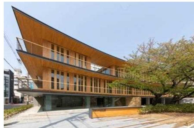
3層構成型耐火集成材を主要構造部に用いた事務所
