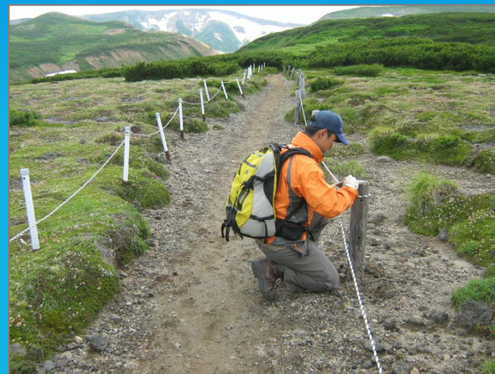
歩道の整備(上川中部森林管理署管内)
