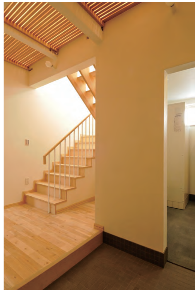
暗くなりがちな玄関ホールは、天井をスノコ状にして2階の明るさを1階に落とすと導く仕掛け。道産シラカバで作った積層ベニヤが使用され、その断面デザインが温かい印象を与える。上がり框には再生紙を挟み意匠性を高めた合板「ペーパーウッド」を採用
