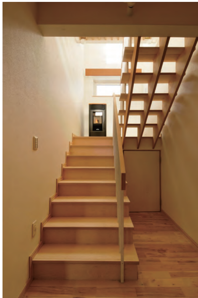
北側の安定した光で一日中明るい階段室。家の中心に位置し、1階と2階をつなぐ階段の踊り場にペレットストーブを置くことで、各部屋からほぼ等距離に暖房熱源を確保した。踊り場の床はレンガタイル仕上げでストーブの輻射熱を蓄熱。階段下にはペレットの備蓄スペースも
