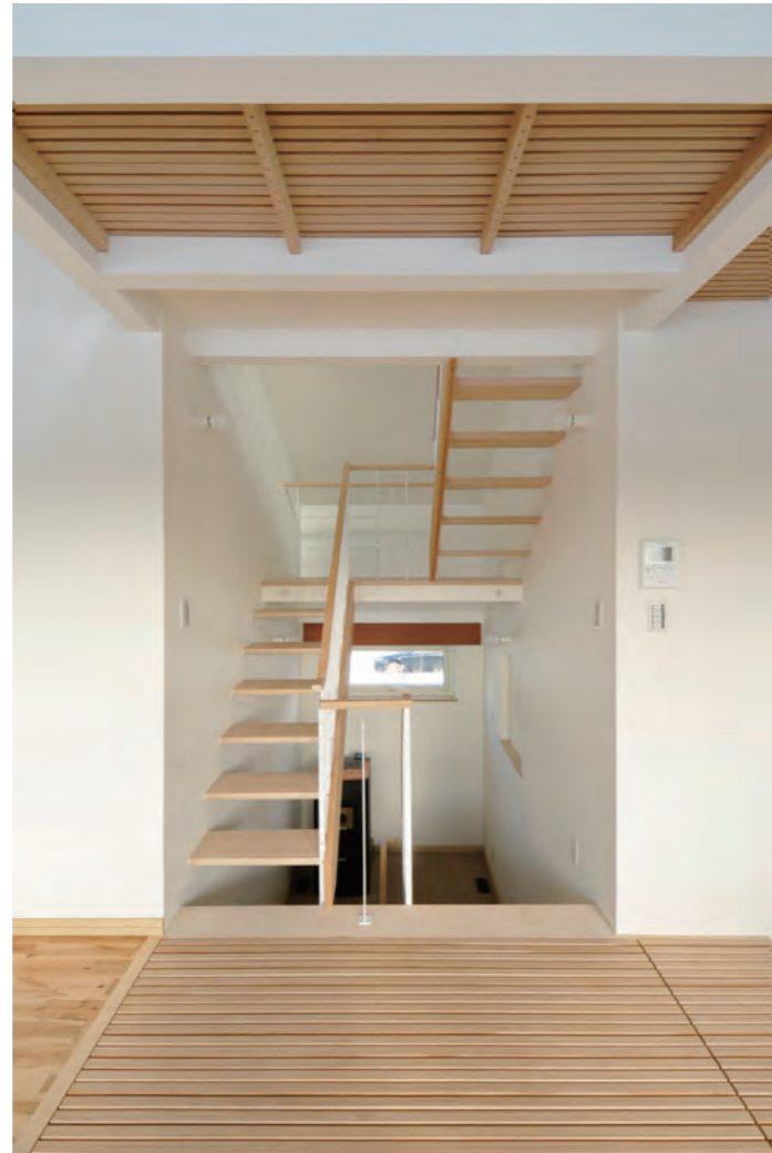
積層ベニヤで作られた階段が目を引き洒落た空間。1階から踊り場までが箱階段、踊り場から2階へは3列のササラ柵階段、2階からロフトへは片持ちのササラ階段と、3種類の階段スタイルを使い分けている
