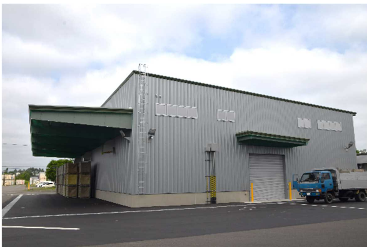
☆ JA 道央の「広域小麦保管倉庫」（恵庭市）
