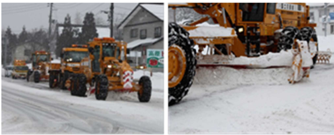
写真-9 新型除雪グレーダの梯団除雪作業状況
