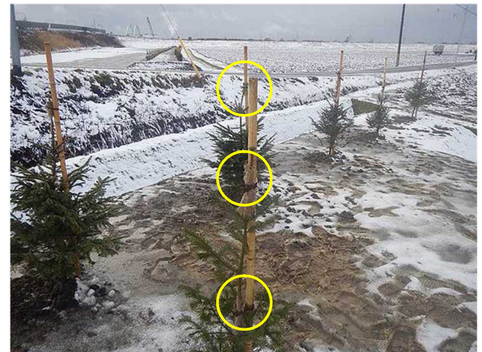
写真5.2.1 竹支柱による基本林の苗木の固定状況
