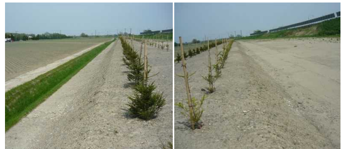
写真6.2 基本林の配植状況(左: 民地側、右: 道路側)
