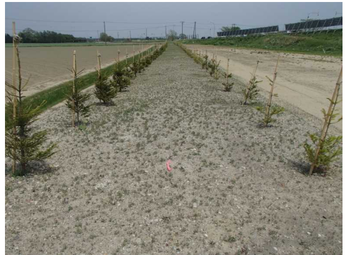
写真6.1 防雪林造成状況
