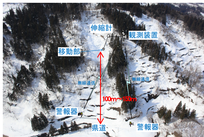
図6 設置事例 (新潟県上越地方)
