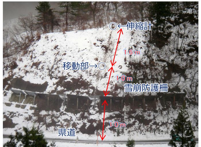
図 3 設置事例 (新潟県中越地方①)
