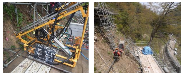
写真-8 施工状況
