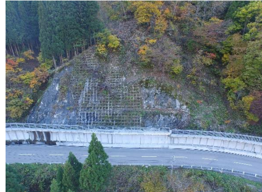
写真-7 雪崩予防杭工（施工前）
