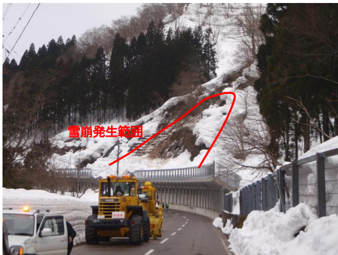
写真-1 雪崩発生直後の状況
