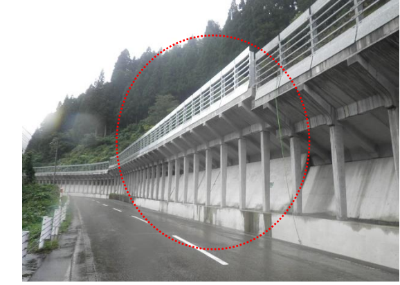
写真-6 復旧後の全景
