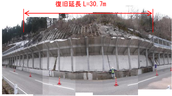
写真-5 復旧箇所全景
