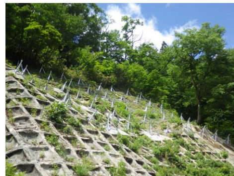
写真-9 雪崩予防杭工（施工後）
