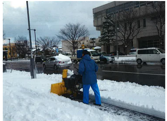
写真2 住民協力によるの歩道除雪の様子
