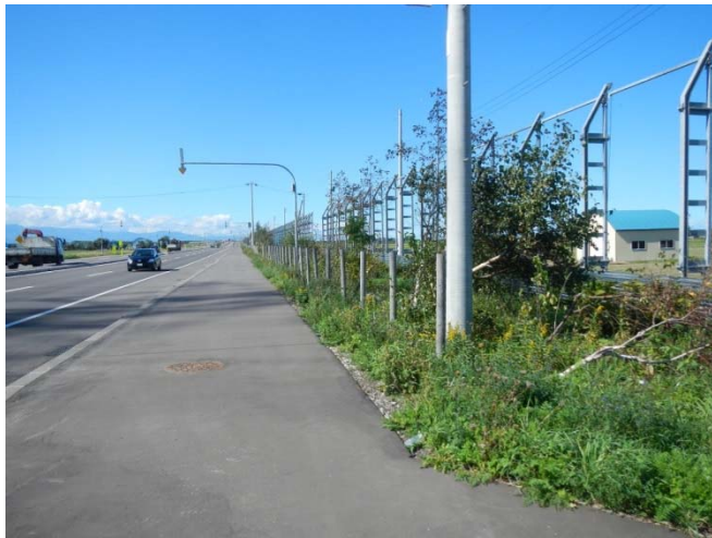
写真2 一般国道337号当別バイパスの除雪害
