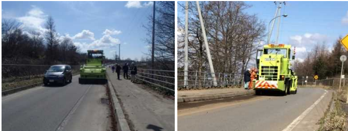
写真-3 作業状況（側道部）
