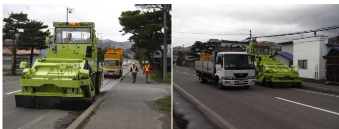
写真-4 作業状況（2車線道路）
