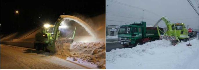
写真-2 除排雪状況写真 (左：拡幅除雪作業 右：運搬排雪作業)
