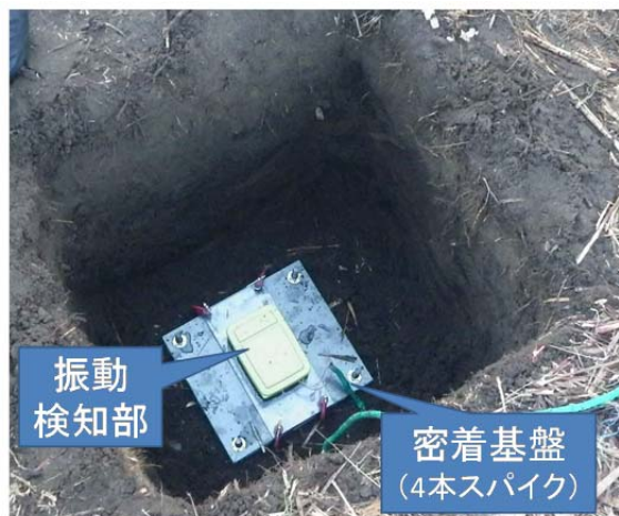
写真-3 検知部設置状況
