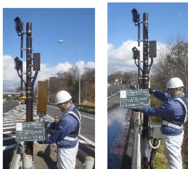
写真-2 車両センサー（2車線対応）
