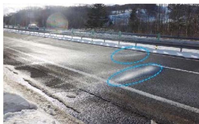
写真-3 凍結防止剤散布状況
