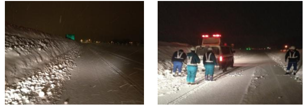
写真-1 路肩の堆雪状況と合同巡回による幅員確認状況
