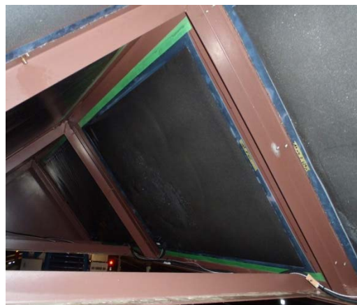
写真4 設置状況 (屋根内部)
