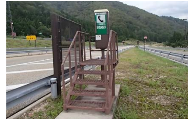
写真15 東海北陸道 非常電話設置状況（富山市） 降雪前
