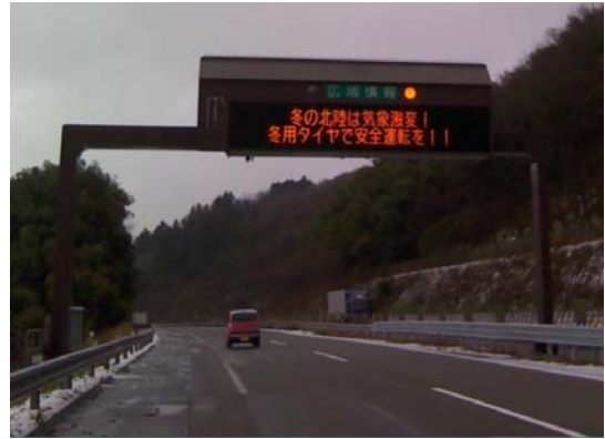
写真9 広域情報板 北陸自動車道 小矢部市
