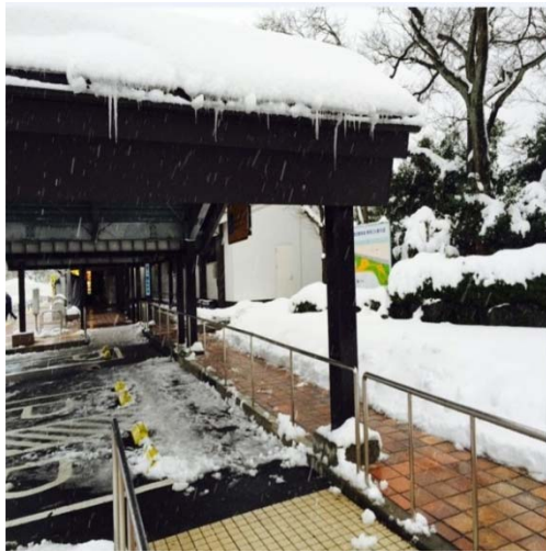
写真13 ヒーター無し 北陸自動車道 南条SA駐車场上屋
