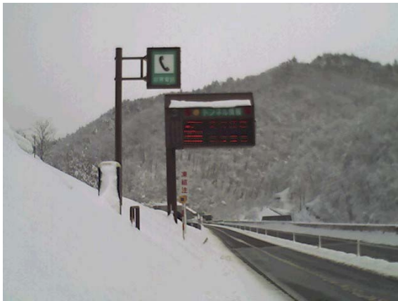
写真7 設置状況 上小島TN上り線
