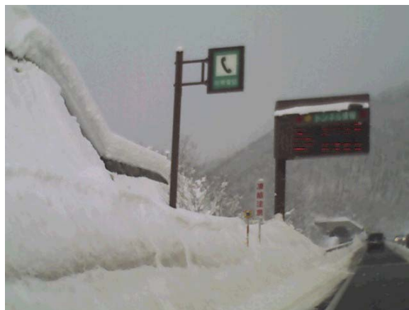
写真5 設置状況 上小鳥TN上り線
