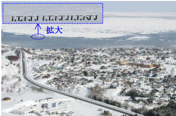
写真-3 防水柵による海水の制御状況
