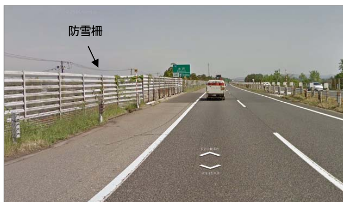
写真-1 東北道下り前沢SA~水沢IC間防雪柵設置状況
