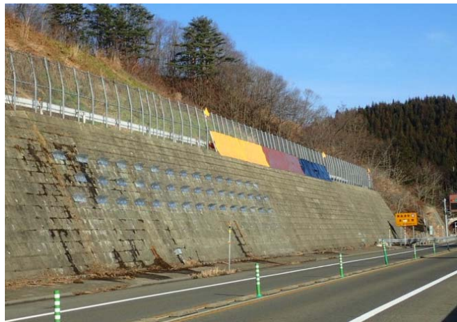
写真-6 完成写真(全景)
