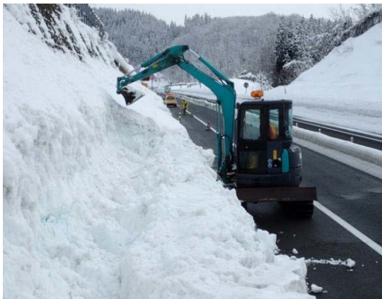
写真-3 重機による堆雪ポケット作成状況
