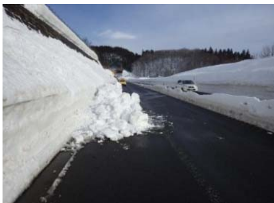
写真-2 落雪状況写真(本線路肩部)
