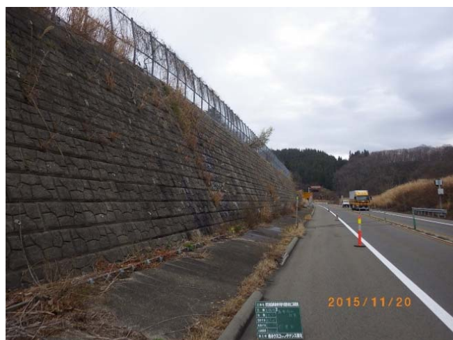
写真-5 施工前写真
