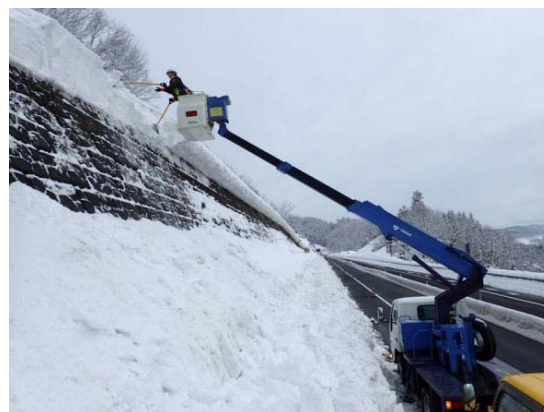
写真-4 人力による雪庇落とし状況
