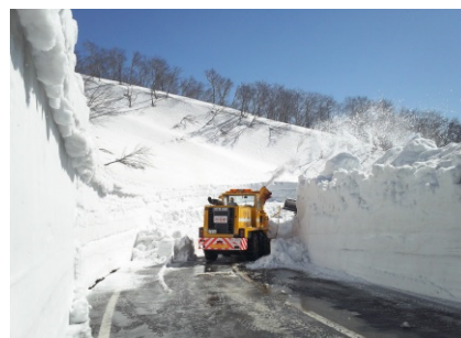
図7. 春山除雪作業（ロータリー除雪車）
