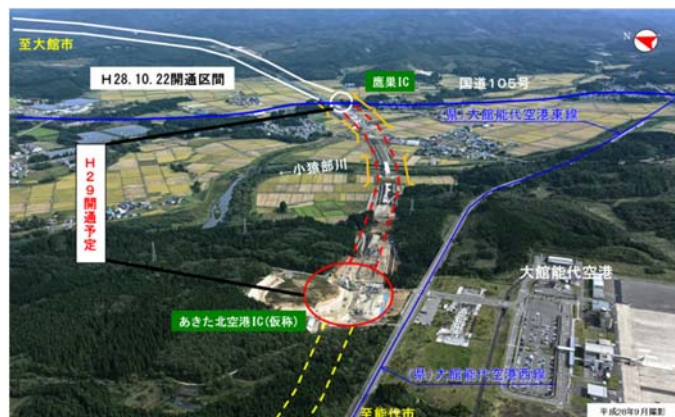
写真 20 整備中のあきた北空港IC（仮称）付近の状況
