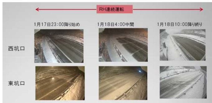
図5 関都トンネル両坑口積雪状況
