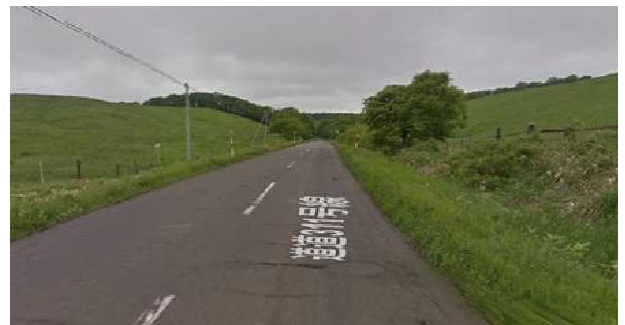
図- 8 十分な堆雪スペースがあり吹きだまりが生じない事例
