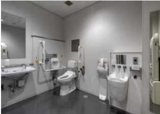
多機能トイレの整備
