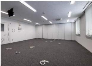
可動間仕切り
