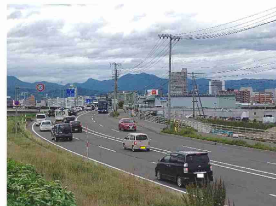
写真：札幌開発建設部（R2.9撮影）
