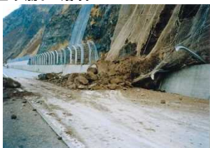
写真: 札幌開発建設部
