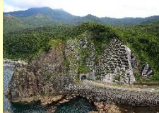
写真: 留萌開発建設部
