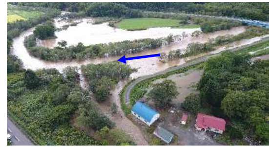
平成29洪水 花石地区
