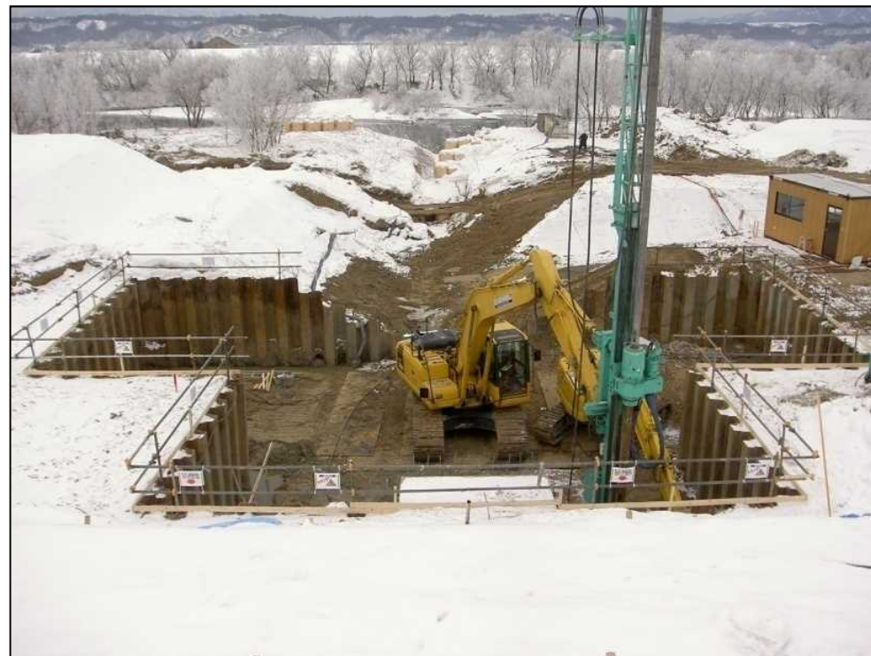
写真6-2 非出水期の樋門改築
