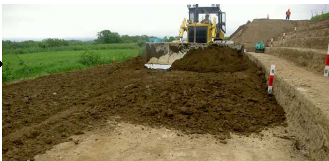
写真6-1 河道掘削残土を用いた堤防整備
