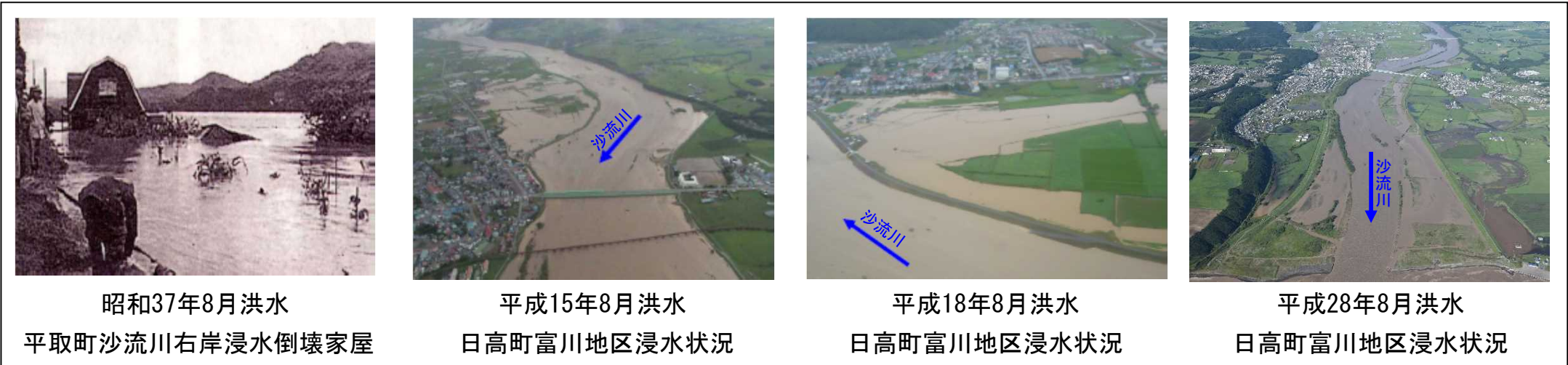
図 2 - 3 洪水被害状況
