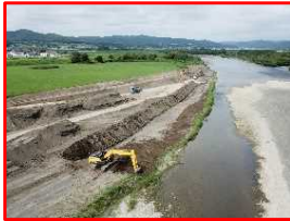
河道掘削（室蘭開発建設部）
