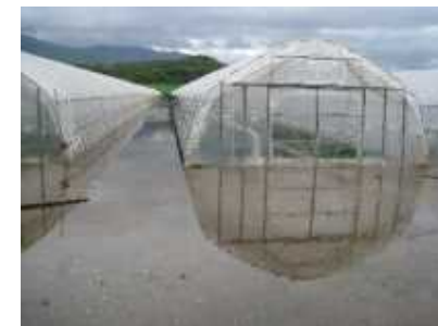
(d) 平成23年9月洪水 (名駒築堤 内水はん濫状況)
