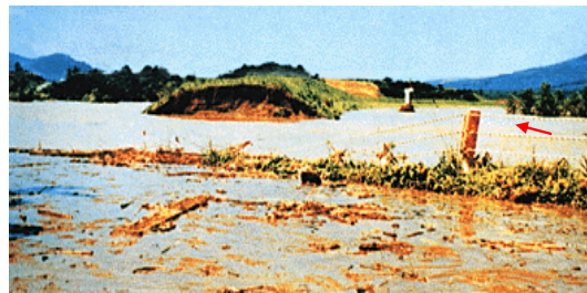
(b) 昭和50年8月下旬洪水 (米子築堤 破堤状況)
