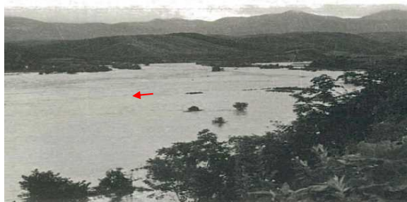
(a) 昭和37年8月洪水 (蘭越町 尻別川左岸はん濫状況)
