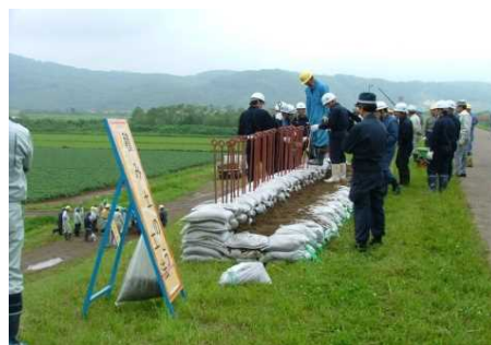
水防工法実技訓練
