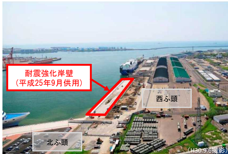
西港区商港地区の耐震強化岸壁の供用状況
