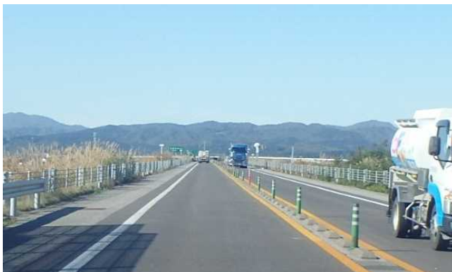
[当初工法] ラバーポールによる簡易分離構造
