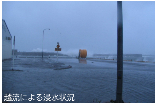
被害状況写真
