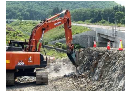
中硬岩の掘削状況
