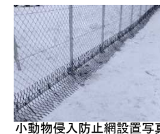
小動物侵入防止網設置写真
