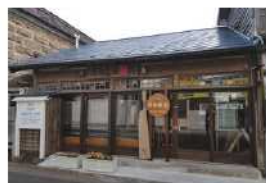
歴史的建築物 「利尻島の駅」の外観
