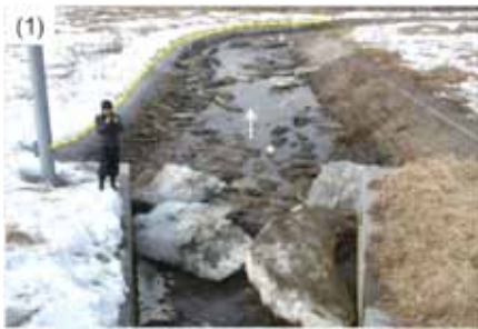
(1) 十勝川T,樋門における氷板痕跡(KP.3.30 R) >
