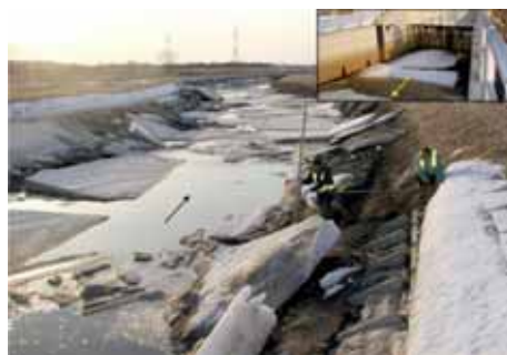
新釧路川K,樋門 (KP.4.50L)における浸水・氷板痕跡及び、ゲート近傍の浮遊氷板(右上)
