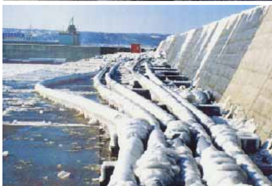
越氷による被害(1991年、網走港南防波堤)
