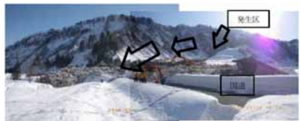
地震による斜面崩壊と雪崩、流動性が高く道路まで到達(新潟県十日町市)
