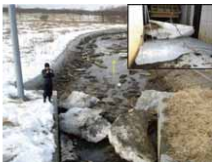
十勝川T,樋門における氷板痕跡(KP.3.30R)
