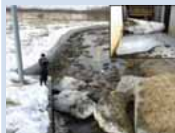
十勝川T,樋門における水板痕跡(KP.3.30R)
