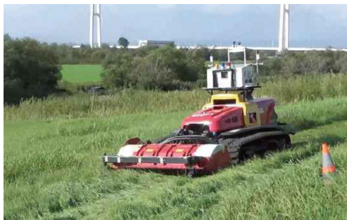
生産性向上の取組 (堤防除草の自動化)
