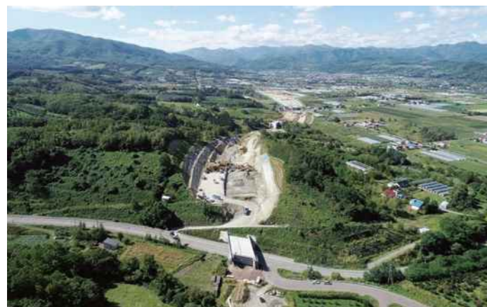
天塩大橋の架設の様子
