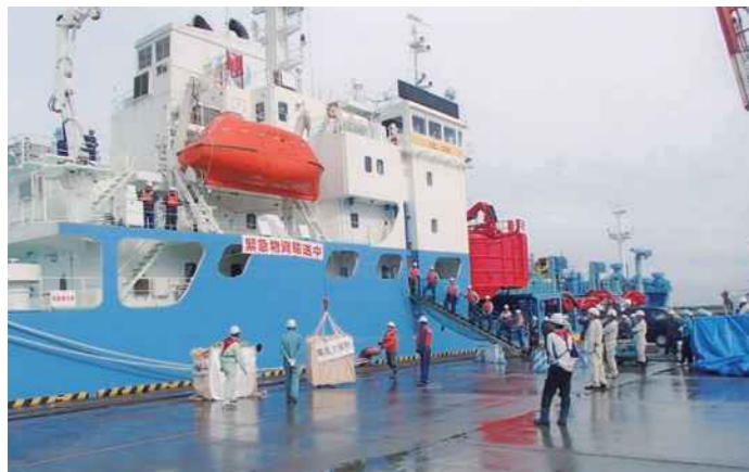
滞船を解消するための岸壁工事が進む苫小牧港 (苫小牧港西港区真古舞地区国際物流ターミナルの岸壁整備)
