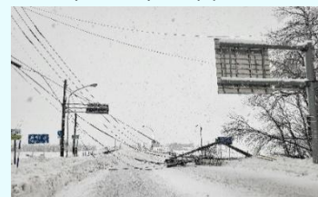
暴風雪による電柱倒壊 (国道38号 幕別町)
