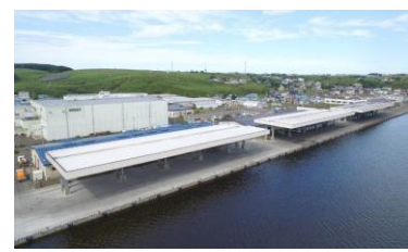
令和7年9月供用 根室港 屋根付き岸壁
