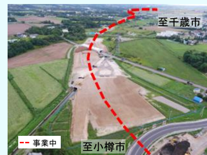
長沼南幌道路 施工状況
