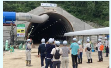
オオヌマトンネルの工事現場
