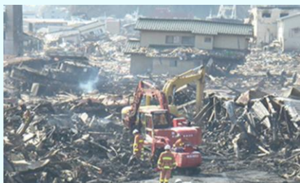
▲道路啓開作業状況
