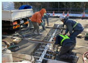
伸縮装置補修
