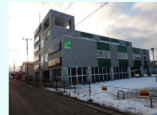
津波避難タワーの整備
