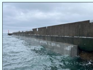
漁港におけるプレキャスト型枠を活用した長寿命化対策
