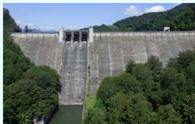
糠平ダム（上士幌町） （治水機能増強検討調査）
