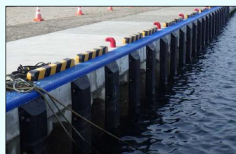
港湾における対策効果例 (矢板が腐食した係留施設を改良し、安全な利用を確保)
