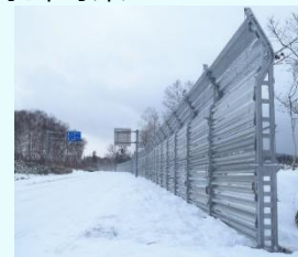
防雪柵の整備
