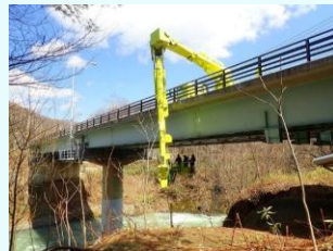
橋梁点検車による点検状況
