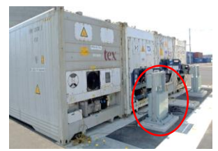
冷凍・冷蔵コンテナ電源供給装置の増設 (石狩湾新港)
