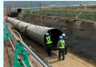
老朽化した農業用用水路の改修
