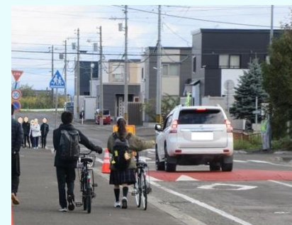
可搬式ハンブ設置状況 (富良野市)
