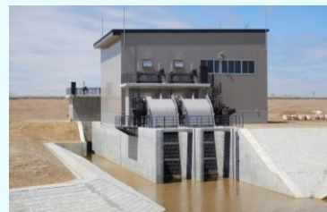
排水機場の更新
