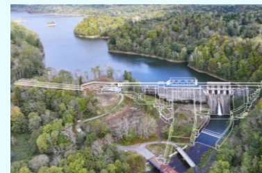
雨竜第2ダム（幌加内町） （堤体嵩上げ・容量振替）
