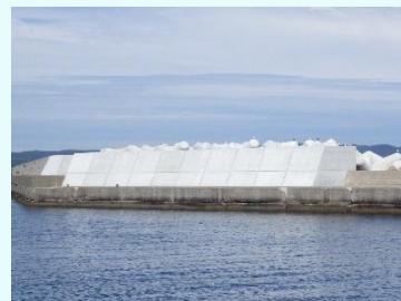
対策事例 防波堤の嵩上げ
