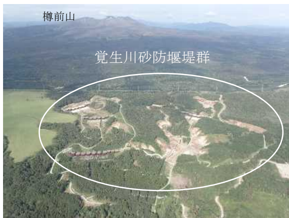
覚生川砂防堰堤群(建設中)
