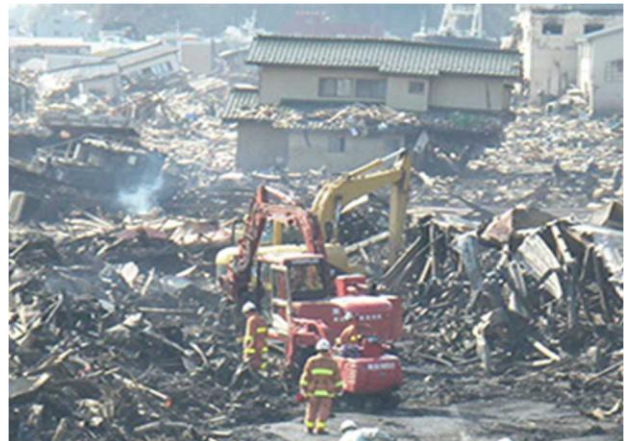
▲道路啓開作業状況
