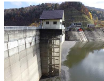
耐震化が必要な取水塔
