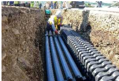
浅層埋設、角型多条電線管の施工 （国道5号 七飯町）
