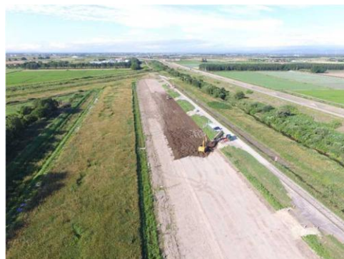
千歳川の堤防整備
