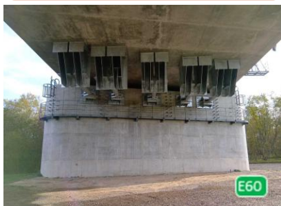
E60 帯広・広尾自動車道（対策事例）
