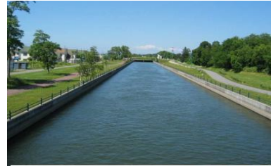
更新整備された用水路
