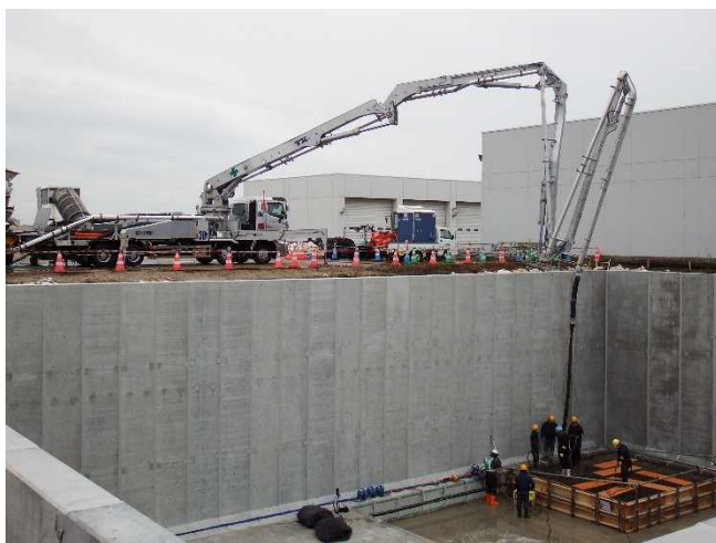
浸水対策(函館空港)
