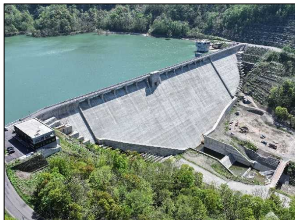
新桂沢ダム（令和6年3月完成）
