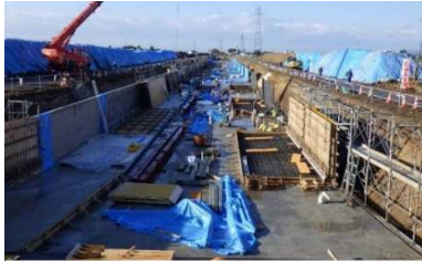
用水路の改修工事
