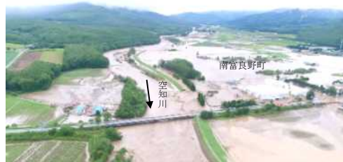
石狩川水系空知川の堤防決壊状況（平成28年8月）
