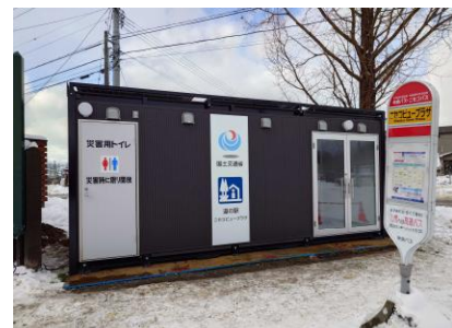
道の駅ニセコビュープラザ（設置事例）
