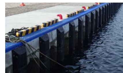
岸壁の老朽化対策例
