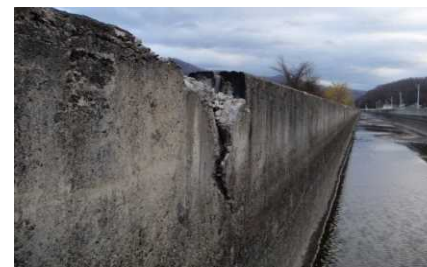
凍害による用水路側壁の亀裂
