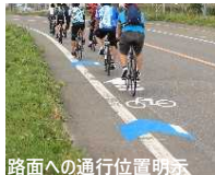
路面への通行位置明示
