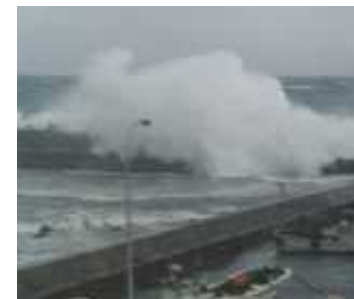
防波堤からの越波 (江良漁港)
