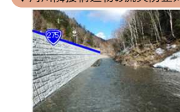
国道275号 対策事例
