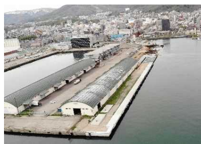
小樽港第3号ふ頭整備状況 (2021年5月時点)
