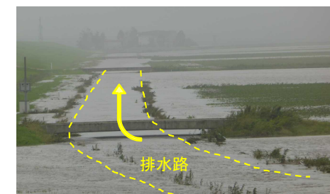
大雨時の湛水被害
