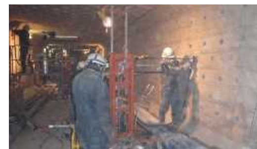
地下構造物の耐震補強
