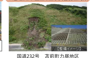
国道232号 苫前町力基地区
