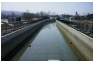
改修後の用水路
