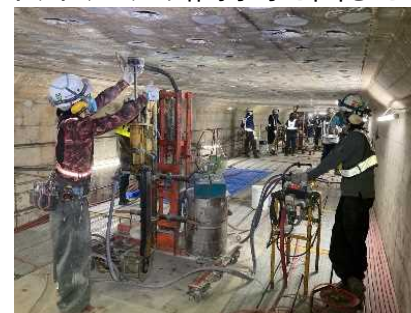
地下構造物の耐震対策 (新千歳空港)
