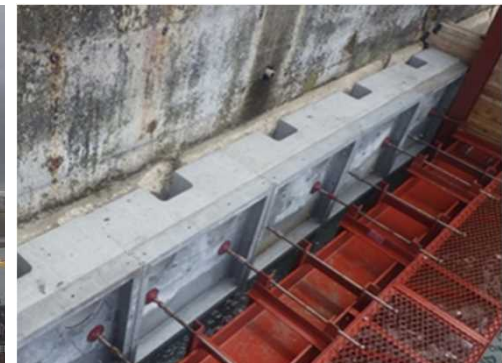
新技術 (本土工被覆) を活用した長寿命化対策 (様似漁港)
