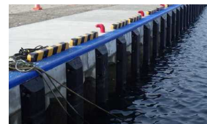
岸壁の老朽化対策例
