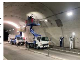
トンネル定期 点検状況 (国道38号 北の峰トンネル)
