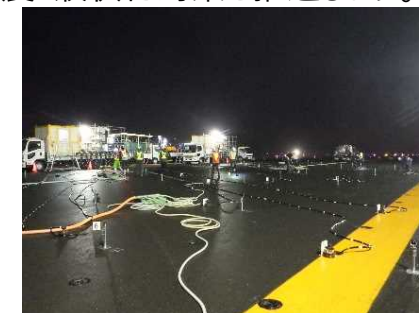
滑走路の液状化対策 (新千歳空港)
