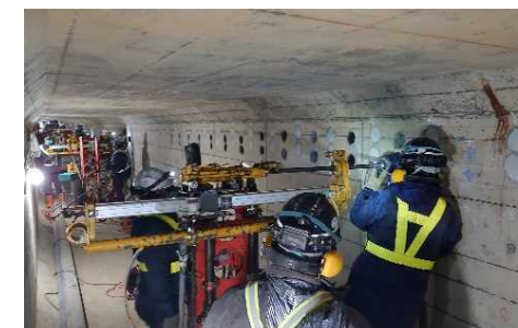
地下構造物の耐震補強
