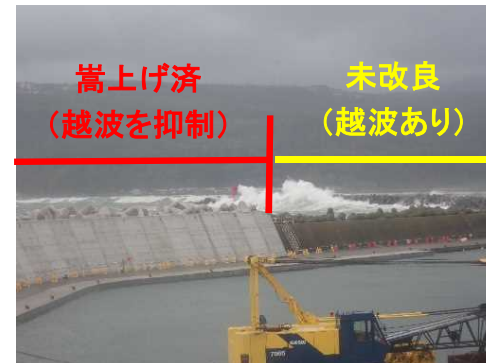
防波堤の高上げによる越波対策 (古平漁港)
