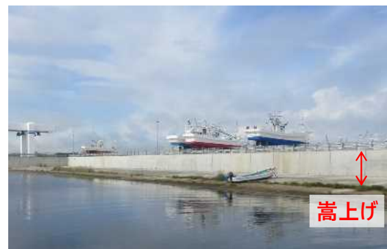
漁船保管施設用地の高上げによる防災対策 (大津漁港)
