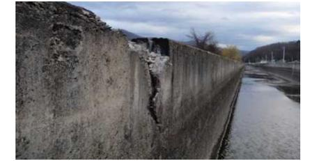
凍害による用水路側壁の亀裂
