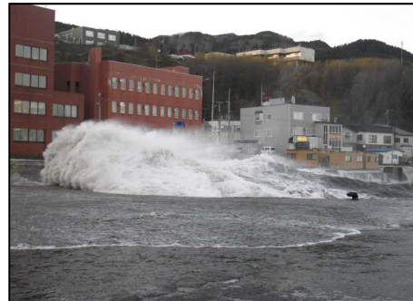
荒天時の越波等による港内擾乱(香深港)
