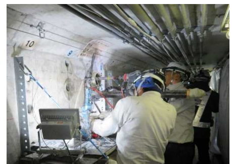
函館耐震対策施工状況
