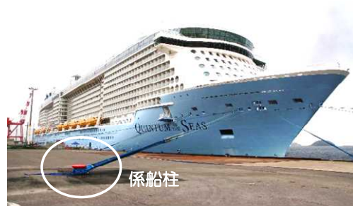
大型クルーズ船に対応した係船柱の設置
