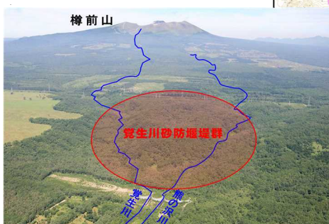
覚生川砂防堰堤群(建設中)
