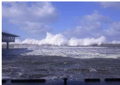
防波堤からの越波状況 (ウトロ漁港)
