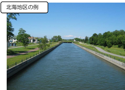
更新整備した用水路
