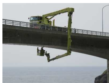
橋梁の点検状況
