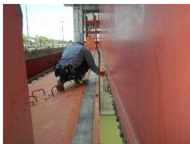
施設の点検（水門ゲート設備）
