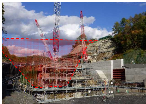
本体工事状況（平成29年10月撮影）
