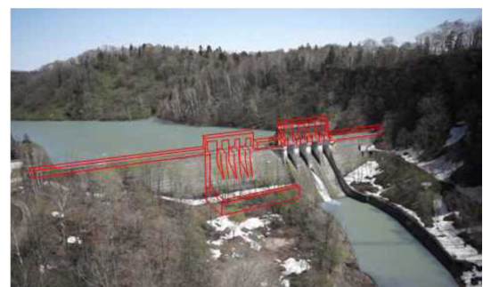
かさ上げイメージ図（雨竜第2ダム）
