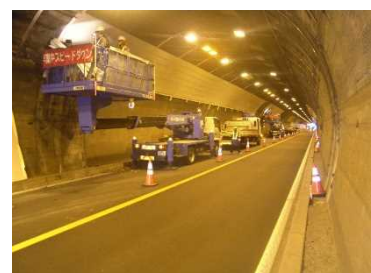
トンネルの点検状況
