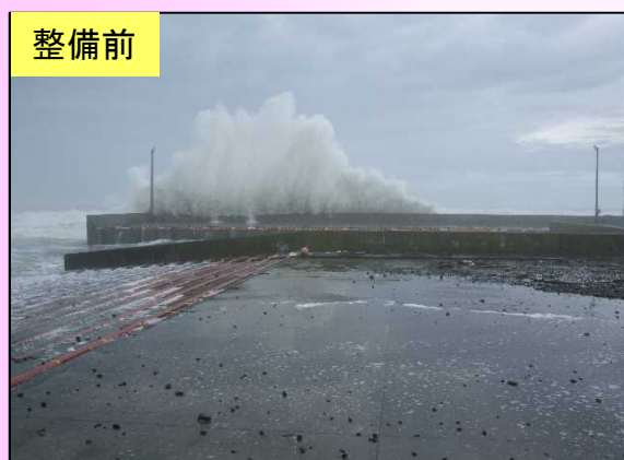
防波堤等の拡幅や嵩上げによる越波対策
