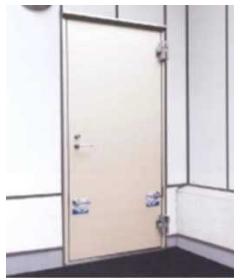
防水扉の設置
