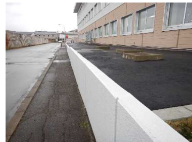
舗装による洗掘防止
