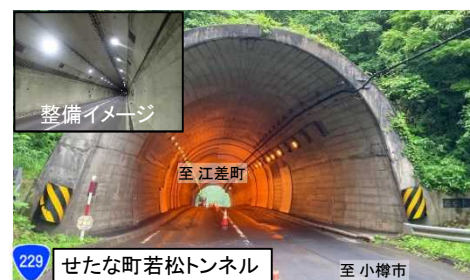
〈道路照明灯のLED化〉
