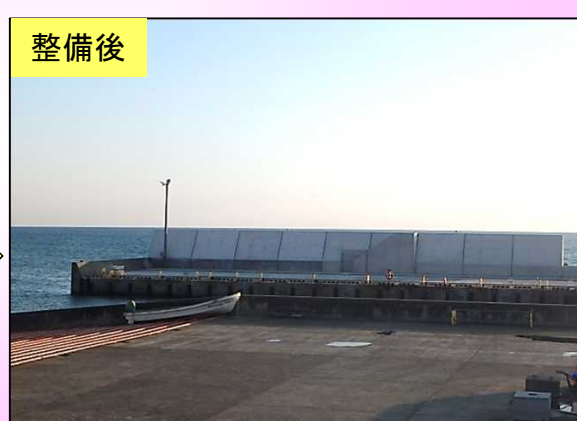
防波堤等の拡幅や嵩上げによる越波対策
