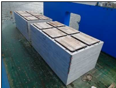
対策例(防波堤延伸のためのケーソン製作)
