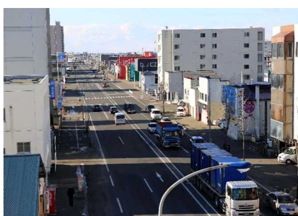
〈道路の防災性向上に資する無電柱化〉
