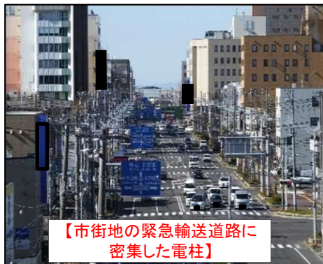
〈市街地の緊急輸送道路等における無電柱化〉
