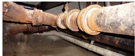
給排水管の状況
