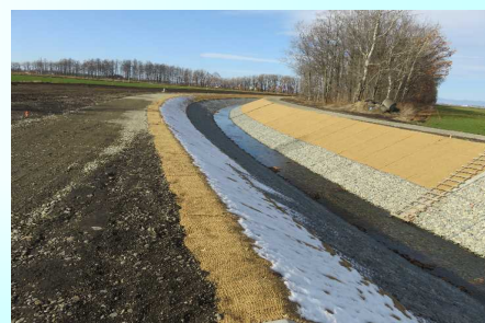
整備された農業用排水路
