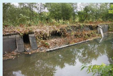
老朽化により倒壊した用水路
