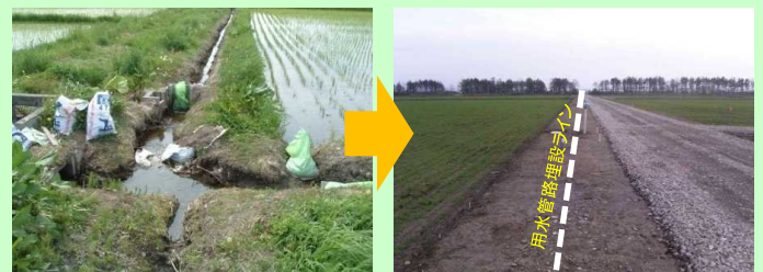
用水路をパイプライン化して、管理作業を大幅に短縮
