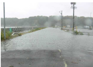
臨港道路の冠水
