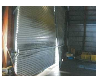
上屋シャッターの破損
